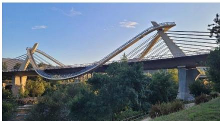
Le Pont du Millénaire, ou "Puente del Milenio", est un ouvrage emblématique d'Ourense, en Galice, inauguré en 2001 pour célébrer le nouveau millénaire. Conçu par l'architecte Álvaro Varela de Ugarte, il mesure 275 mètres de longueur et 23 mètres de largeur, avec une travée centrale de 36 mètres. Sa structure en béton et acier comprend quatre voies de circulation et des trottoirs pour les piétons.
